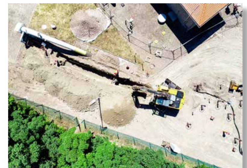
Bau einer Molchschleuse für eine sichere und effiziente Überprüfung von Wasserstoffleitungen
